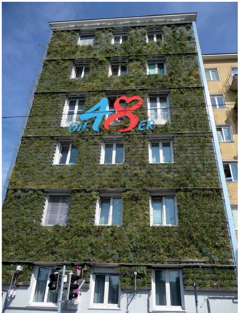
Fassadenbegrünung mit dem Grünwand-System auf einem Gebäude der Magistratsabteilung 48 (Abfallwirtschaft, Straßenreinigung und Fuhrpark) in Wien (5. Bezirk)
